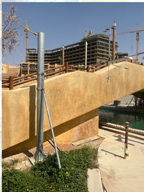
Poteau en acier galvanisé dimensions sur mesures Avec ou sans jambe de force
