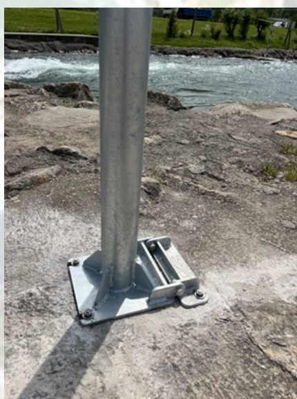
Poteau sur platine articulée (zone inondable)
